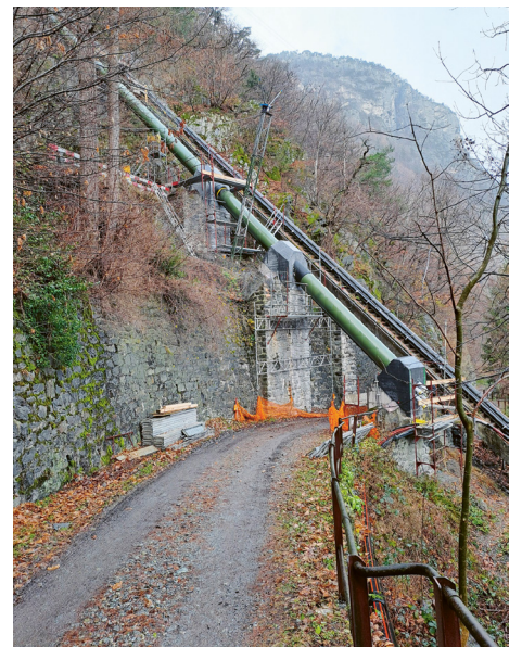
Tube en acier posé à côté de l'escalier du funiculaire
